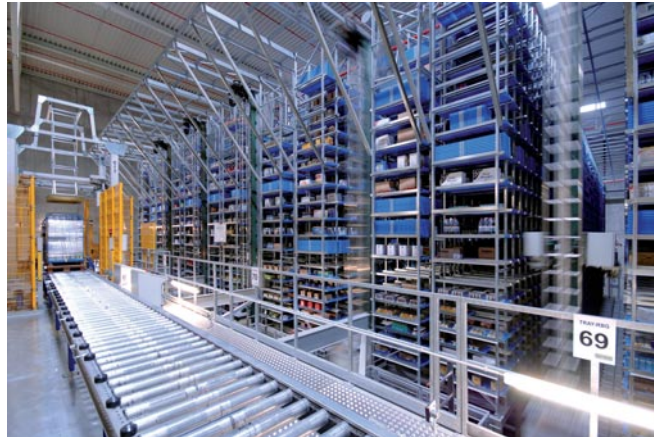
48 couloirs sillonnent les 4 blocs de stockage automatisés.
