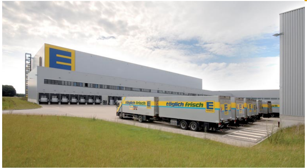
A Hamm-Rhynerm, Edeka a investi dans l'un des centres de distribution les plus grands et les plus modernes pour l'alimentaire en Allemagne.
