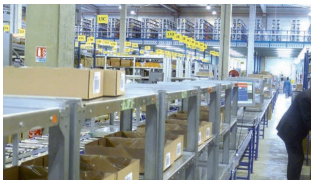
Convoyeur à gares permettant de préparer 1500 colis à l'heure
