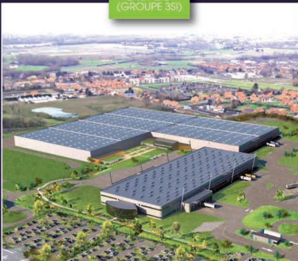
Plateforme logistique automatisée e-commerce (40 000 m 2 )
