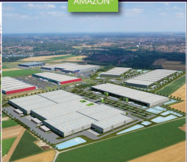
Centre de préparation de commandes e-commerce (90 000 m 2 ) financé par Goodman
